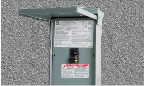
Quand l'eau au bon niveau, mettez le spa en marche au niveau du disjoncteur GFCI. (Assurez-vous de raccorder les spas fonctionnant sur du 120 V au circuit électrique approprié.)
