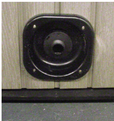
Figure 12. Soupape de vidange montée sur la jupe
