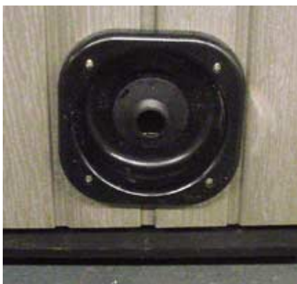
Figure 18. Soupape de vidange montée sur la jupe
